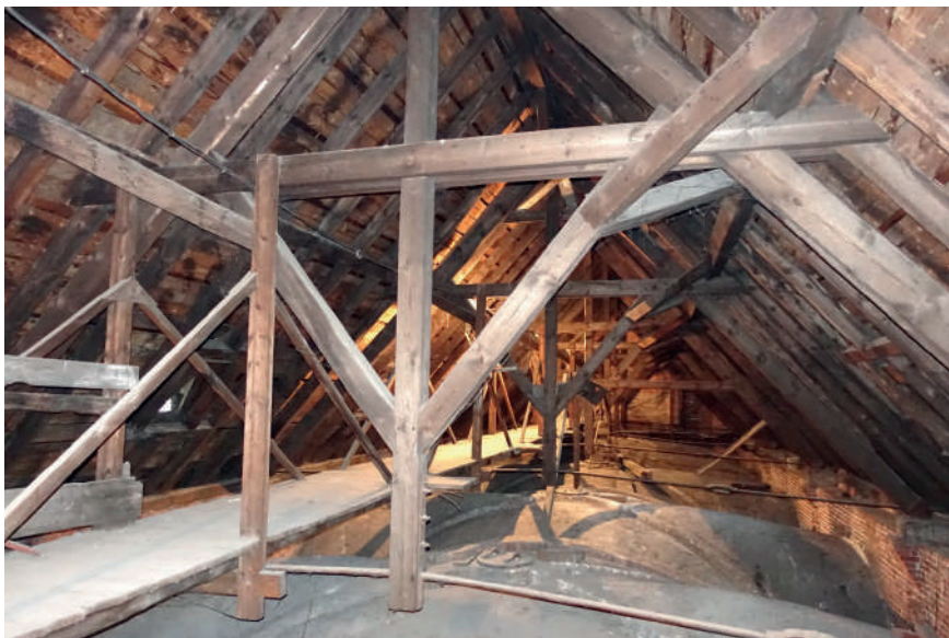
Rys. 99. Więżba wieszarowa nad nawą. Wiażar pełny ze ściągami stalowymi i widoczną podwieszoną do niego kładką drewnianą
