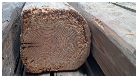
Rys. 9. Przykłady aktywności owadów: a) spichlerz w Przyszowicach (XVIII w), b) chata w Chełmie Śląskim (XIX w.), c) i d) Wieża kościelna w Turośni Kościelnej 1870 r.
