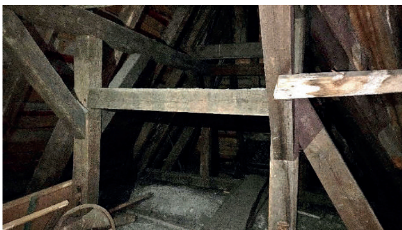
Rys. 98. Więżba wieszarowa dachu niższego
