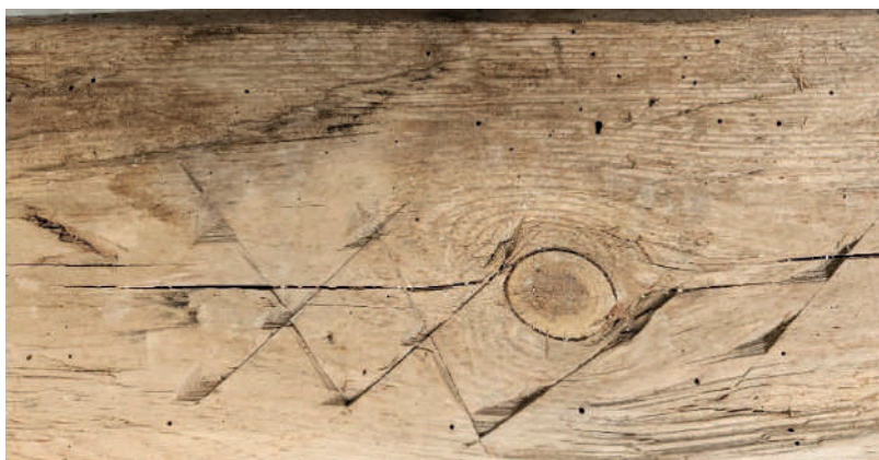
Rys. 62. Inskrypcje i oznaczenia na pozyskanych belkach: a) „ANNO 1743 DIE 19IVLI IK” (belka IX-1), b) ciesielski znak montażowy „XXI I” (belka IV-1)
