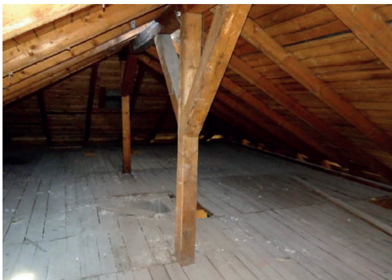
Rys. 92. Górna część więźby dachowej
