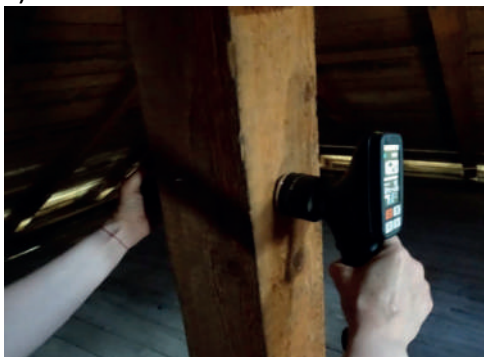
Rys. 95. Badania więźby urządzeniami: a) młotek do drewna Wood Paker DRC, b) UK 1401 SURFER , c) UK 1410 PULSAR
