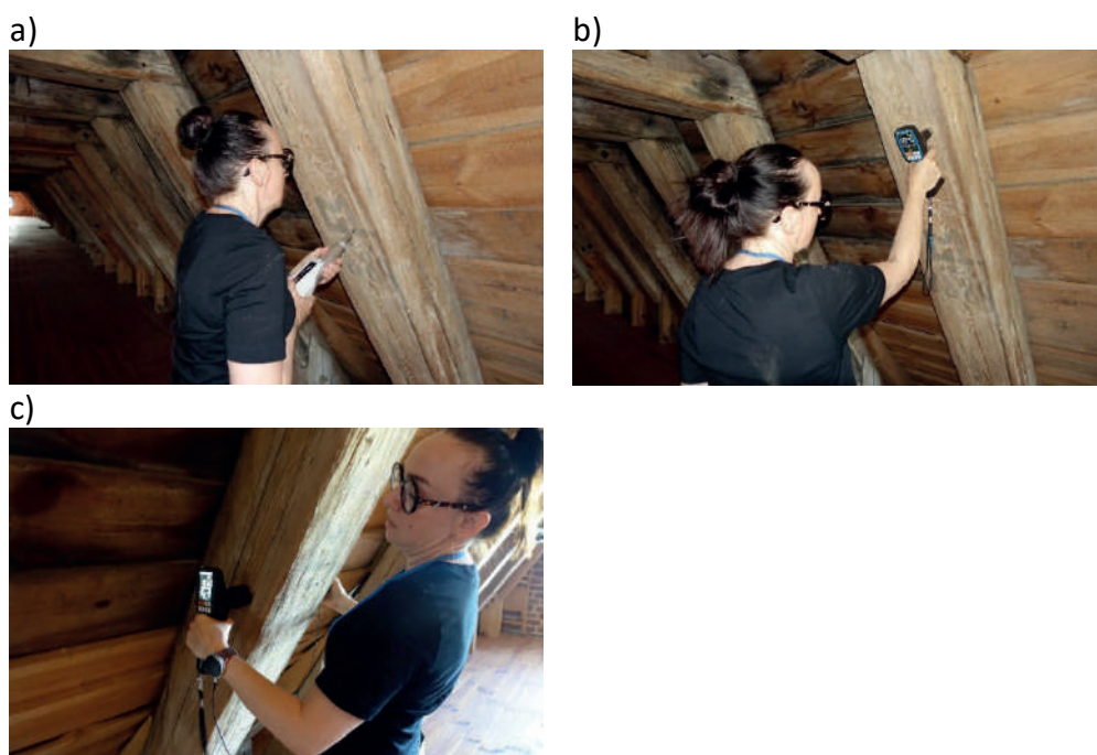
Rys. 107. Badania więźby urządzeniami: a) młotek do drewna Wood Peko DRC, b) UK 1401 SURFER, c) UK 1410 PULSAR
