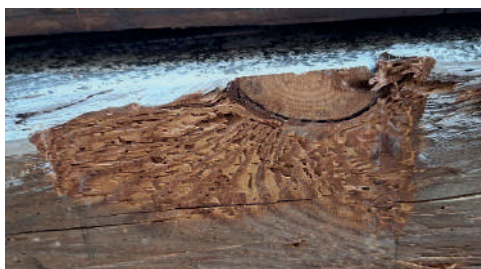
Rys. 9. Przykłady aktywności owadów: a) spichlerz w Przyszowicach (XVIII w), b) chata w Chełmie Śląskim (XIX w.), c) i d) Wieża kościelna w Turośni Kościelnej 1870 r.
