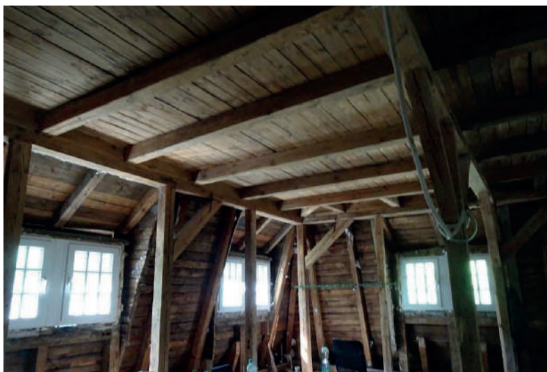
Rys. 93. Dolna część mansardowej więźby budynku
