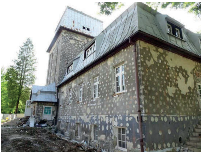
Rys. 91. Widok budynku w trakcie modernizacji
