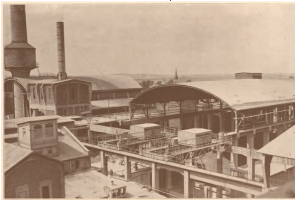
Cementownia Groschowitz, lata 30. XX w.
